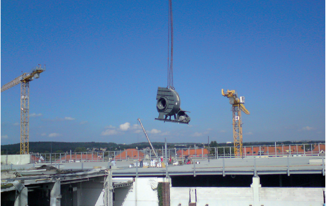
Einkaufszentrum „Elbepark“ in Deutschland
